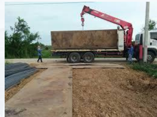
ต้องใช้แผ่นยางรองแผ่นเหล็กสำหรับพื้นถนนชั่วคราว
