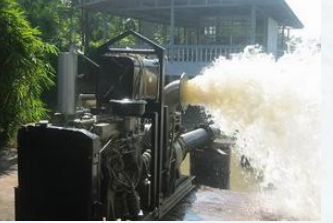
จัดหาเครื่องสูบน้ำ (กรณีต้องเร่งระบายน้ำออก)
