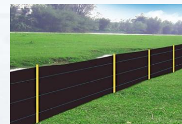
ติดตั้งรั้วดักตะกอนชั่วคราว แบบ Temporary Silt Fence
