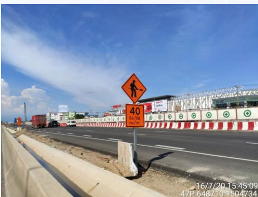
ตั้งป้ายจำกัดความเร็วไม่เกิน 40 กม./ชม.
